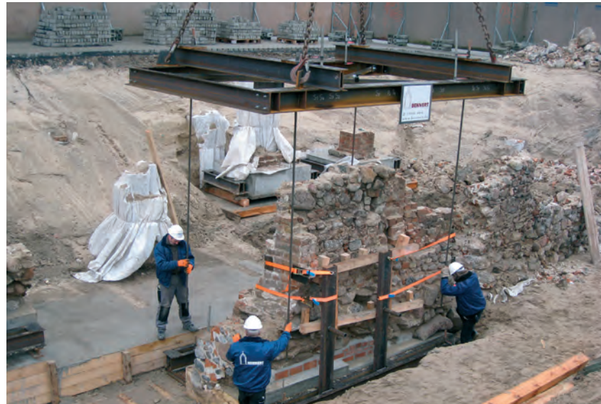
Bergung der Nordwand des Alten Rathauses für die Wiedereinbringung am originalen Standort nach Fertigstellung des U-Bahnhofs
