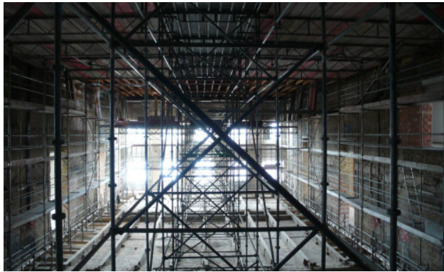
Kaisersaal im Bau, Sommer 2008 @ SMB, KB
