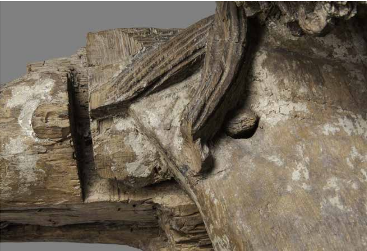
Abb. 17: Fuge zwischen Corpus und Armbohle.
