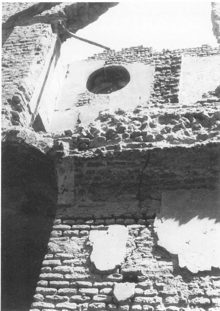
Abb. 6 Zustand der Nebenräume
