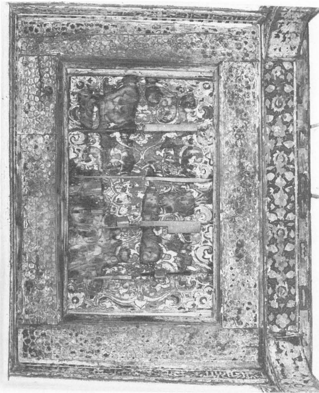
Abb. 4 Schadhafte Holzdecken
