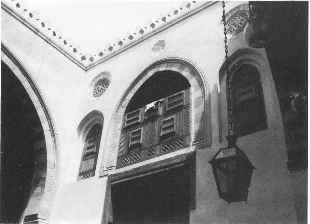
Abb. 3 Zustand des Mauerwerkes des Innenhofes nach der Restaurierung
